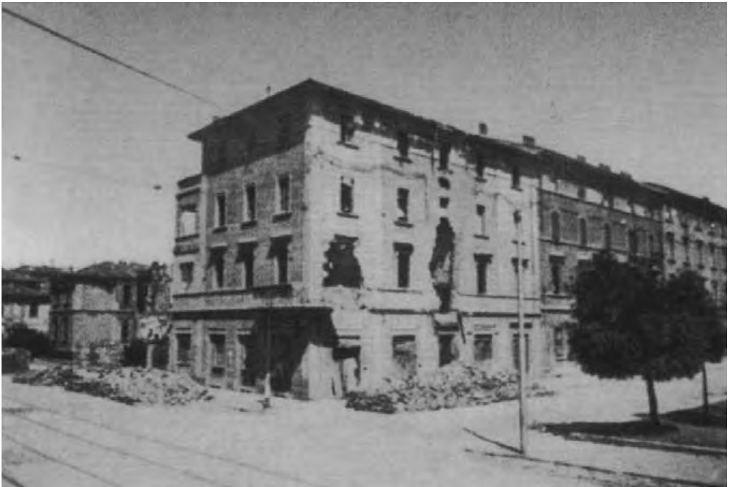
Lo stabile di Piazza dell'Unità dove si acquartierarono diciassette partigiani, dopo Porta Lama, epicentro della nuova battaglia. I muri recano i segni delle cannonate del nemico sparate da un carro armato dislocato a poca distanza, a protezione dei reparti impiegati nel rastrellamento. (Foto archivio ANPI)
