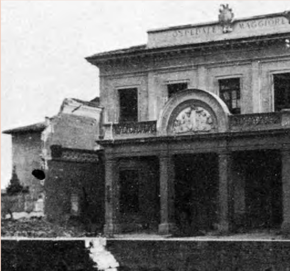
Il frontale dell'Ospedale Maggiore (oggi non più esistente) quando sorgeva in via Riva di Reno affacciato sull'omonimo canale. Si notano le macerie del bombardamento aereo di via Lame. Nei locali abbandonati fu organizzata la permanenza di 230 partigiani. Si scorge la lunetta delle sculture oggi esposta all'ingresso del nuovo complesso sanitario di Santa Viola.
